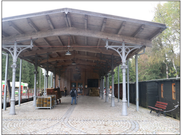
Teile der Überdachung vor dem Bahnhof haben in ihrem ersten „Leben“ am Erfurter Hauptbahnhof gestanden. Fotos (2): Klaus Probst
