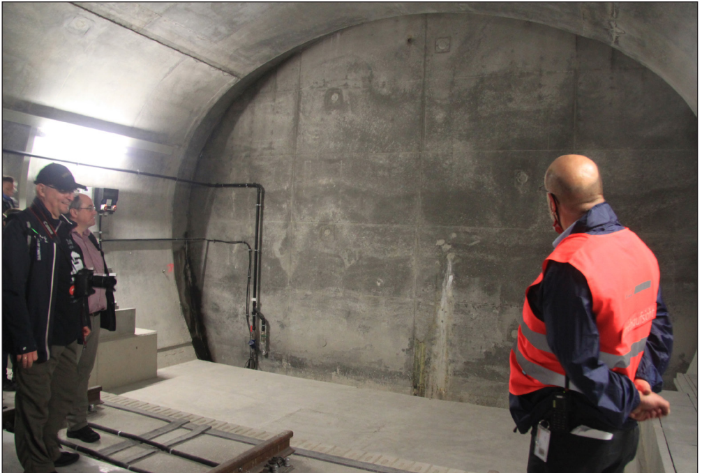
An der von Otwin Krause fotografierten Wand ist die Strecke aktuell zu Ende. In etwa fünf Jahren soll es die Wand nicht mehr geben. Dann soll hier das Gleis zur künftigen Endstation Gebersdorf liegen.
