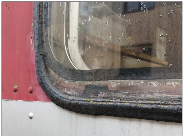
Auf diesem Foto von Michael Mrugalla ist das Problem gut zu erkennen. Die beiden Dichtungen sollten eigentlich auf gleicher Höhe sein.
