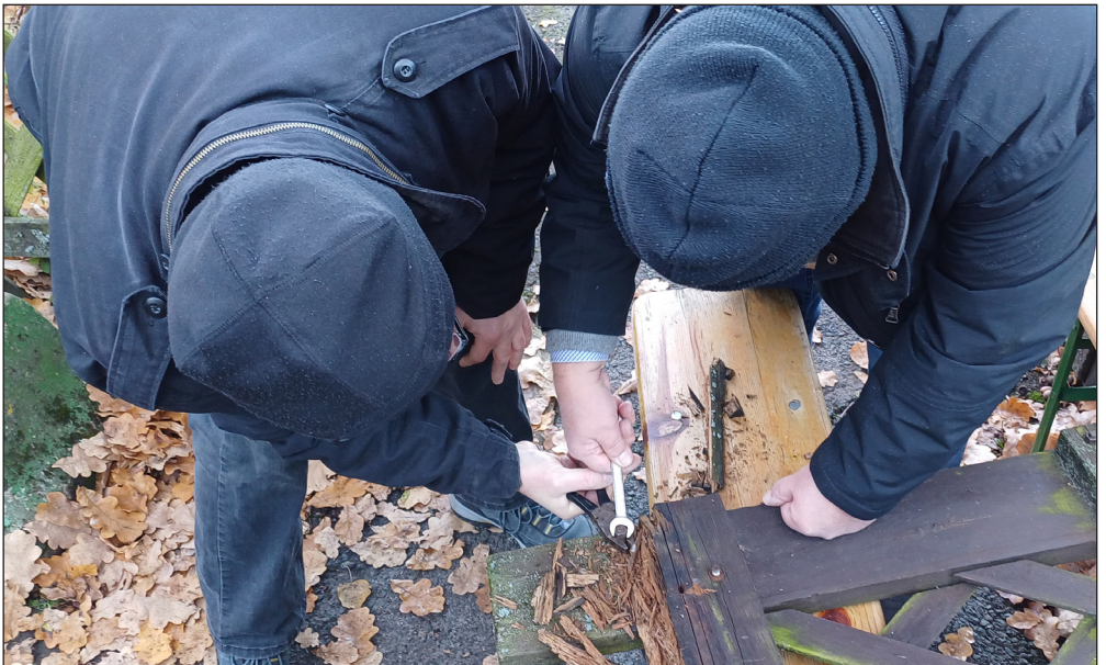
Klaus Probst (links) und Raimund Scheder entfernen die Reste einer Schraube. Im schon in Auflösung begriffenen Holz konnte die Schlossschraube nicht konventionell demontiert werden. Foto: Michael Mrugalla
